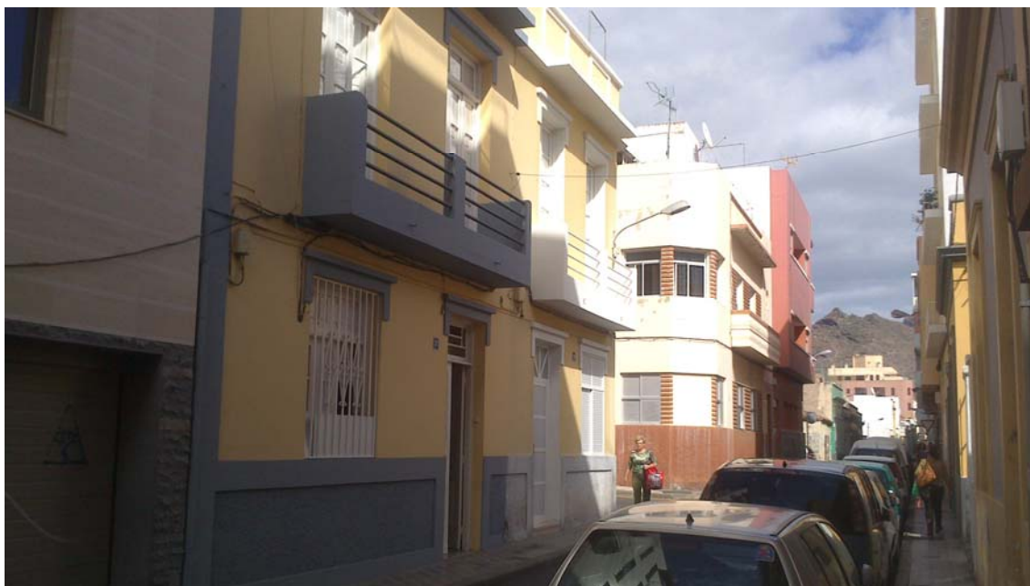
Lámina 19. Edificios eclécticos (calle Santiago, 17 y 19).
